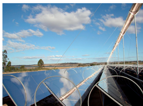
Fresnelovy reflektory solární termální elektrárna Kimberlina, USA (fotografie převzaty z wikipedia.org)
